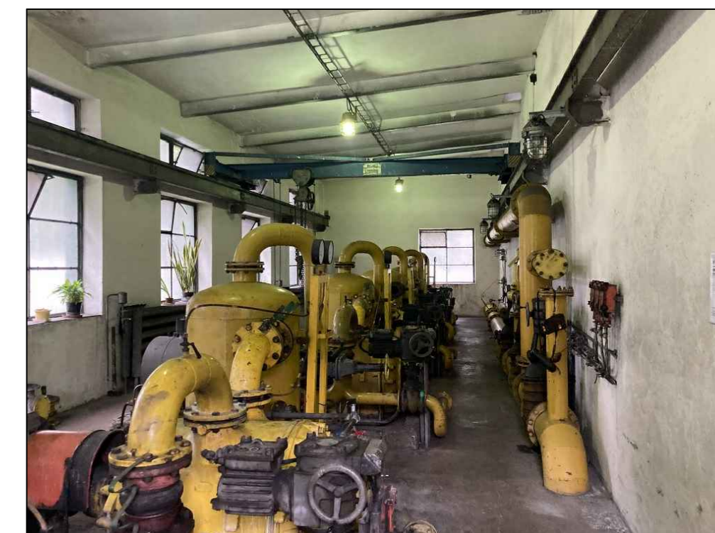
POHLED NA STROJOVNU
